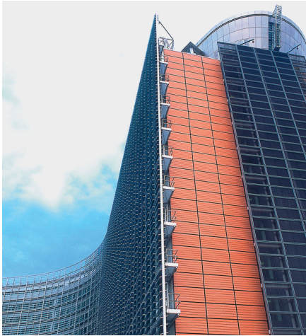
20.000 Quadratmeter Colt-Glaslamellen dienen in diesem EU-Verwaltungsgebäude dem Sonnenschutz und der Wärmeregulierung.
