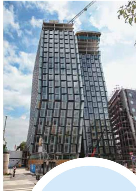
Jedes einzelne Fassadenelement wurde hochgezogen und montiert, über 19.000 Quadratmeter Fassadenfläche insgesamt.
