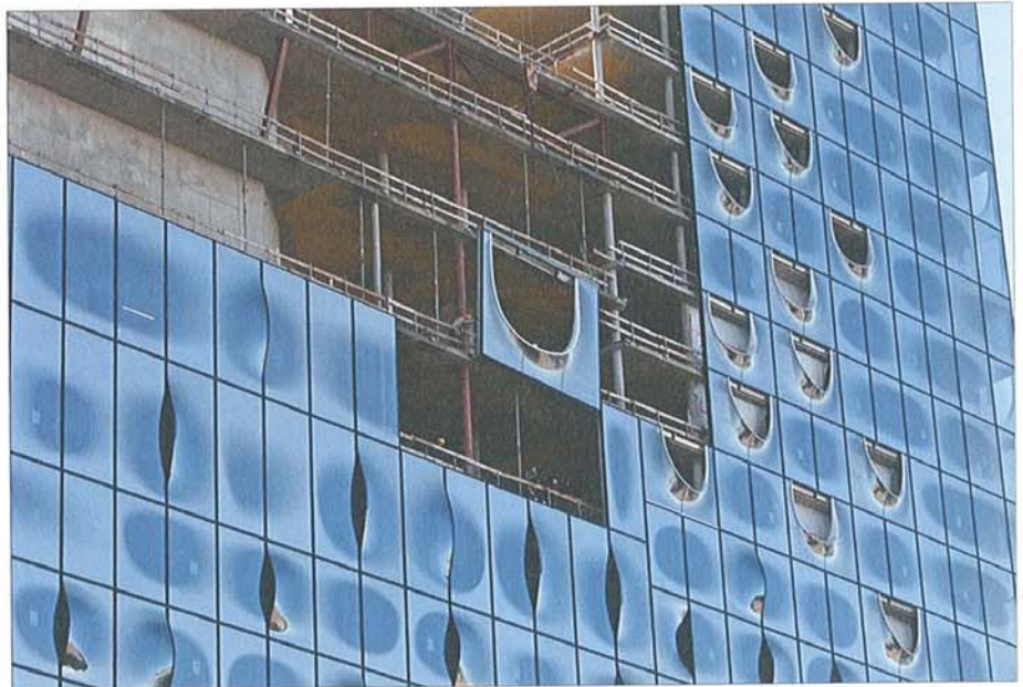
Fassadenbauer Gartner montiert die große Stimmgabel an der Elbphilharmonie Hamburg.
